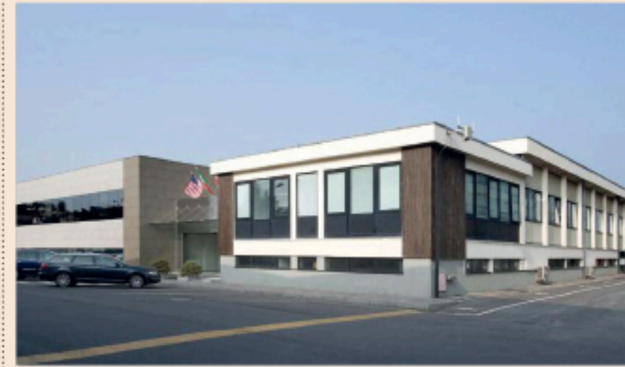
OCV Italia srl, Stabilimento di Besenà in Brianza
